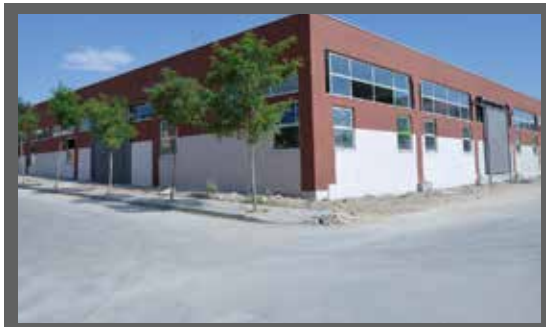
TEPEBAŞI BELEDİYESİ ÇAMLIÇA KAPALI PAZARYERİ Çamlıca Mh. Dayıbey/Okumuşlar Sk.
