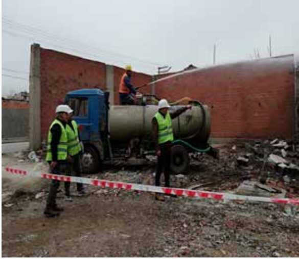
Yıkım öncesi sulama işlemi
